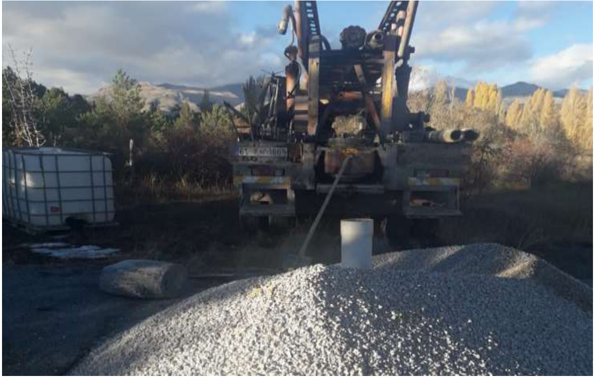
Şiran Çal Köyü İçmesuyu Sondaj Kuyusu Teçhiz Çalışması
