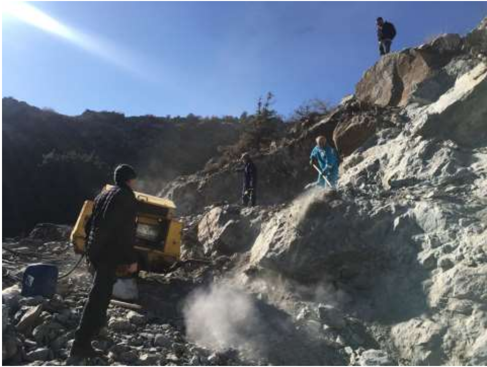
Merkez Dibekli Köyü Yayla Yolu Yapım İşi
