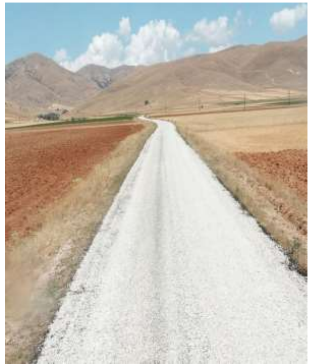
Köse Oylumdere Köyü Asfalt Çalışması
