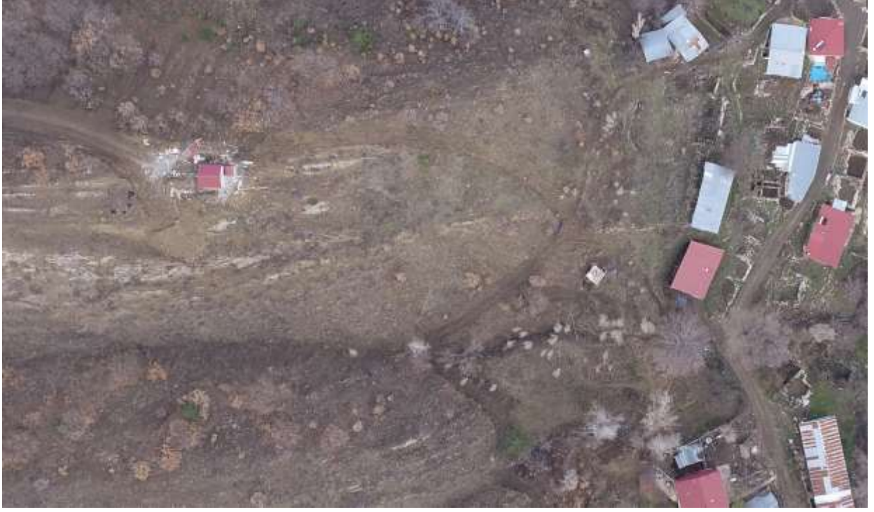
Şiran Başköy İsale Hattı ve Depo Yapım İşi Hava Fotoğrafi
