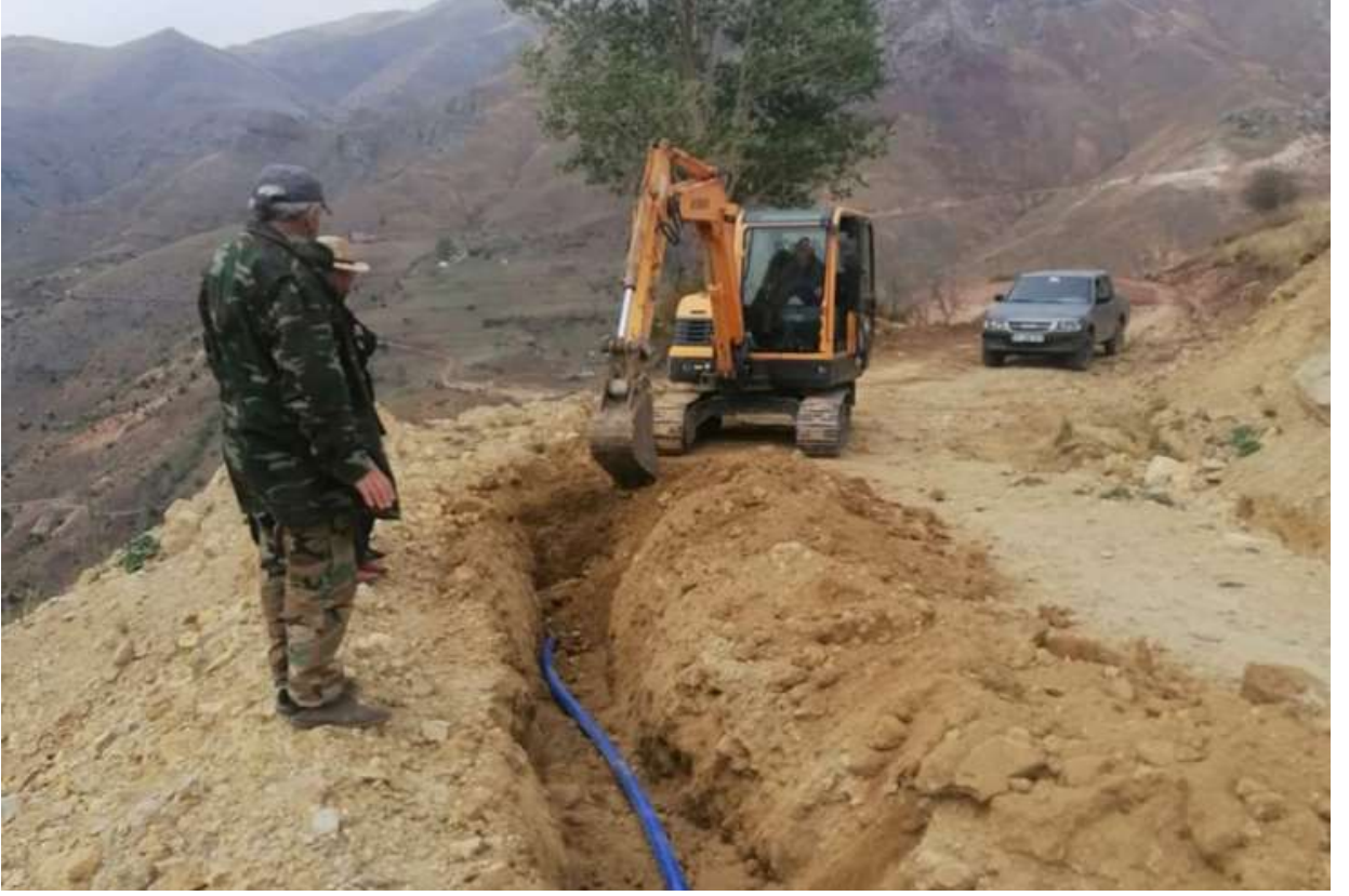
Yağlıdere Köyü İçmesuyu İsale Hattı Kanal Kapatma Çalışması
