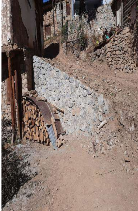
Torul İlçesi Zigana Köyü Dere Mahallesi Kanalizasyon Hattı Yapım Çalışmaları
