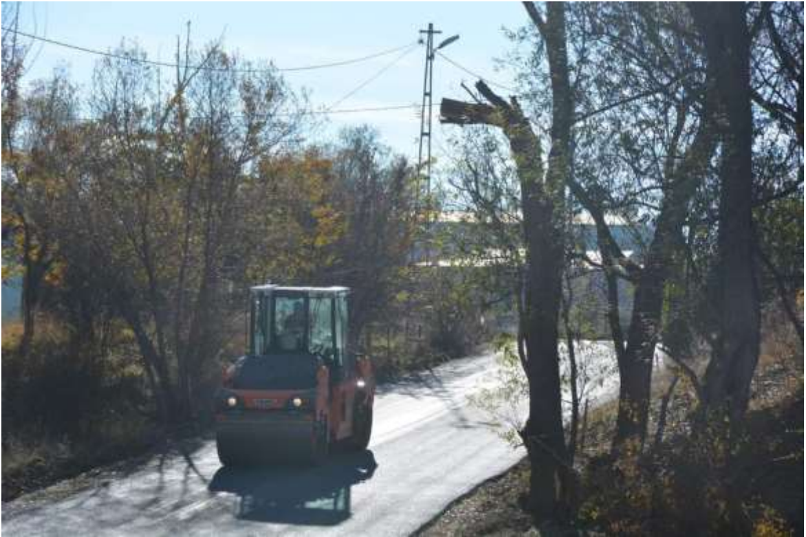
Merkez Sarıççek Köyü Grup Yolu BSK Çalışması
