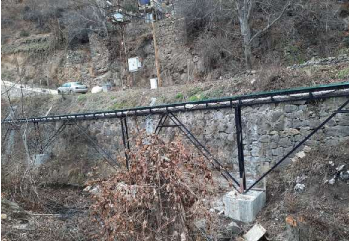
Merkez Yeşilyurt Köyü Kanalizasyon Hattı Yapım İşi Dere Geçişi Platformu
