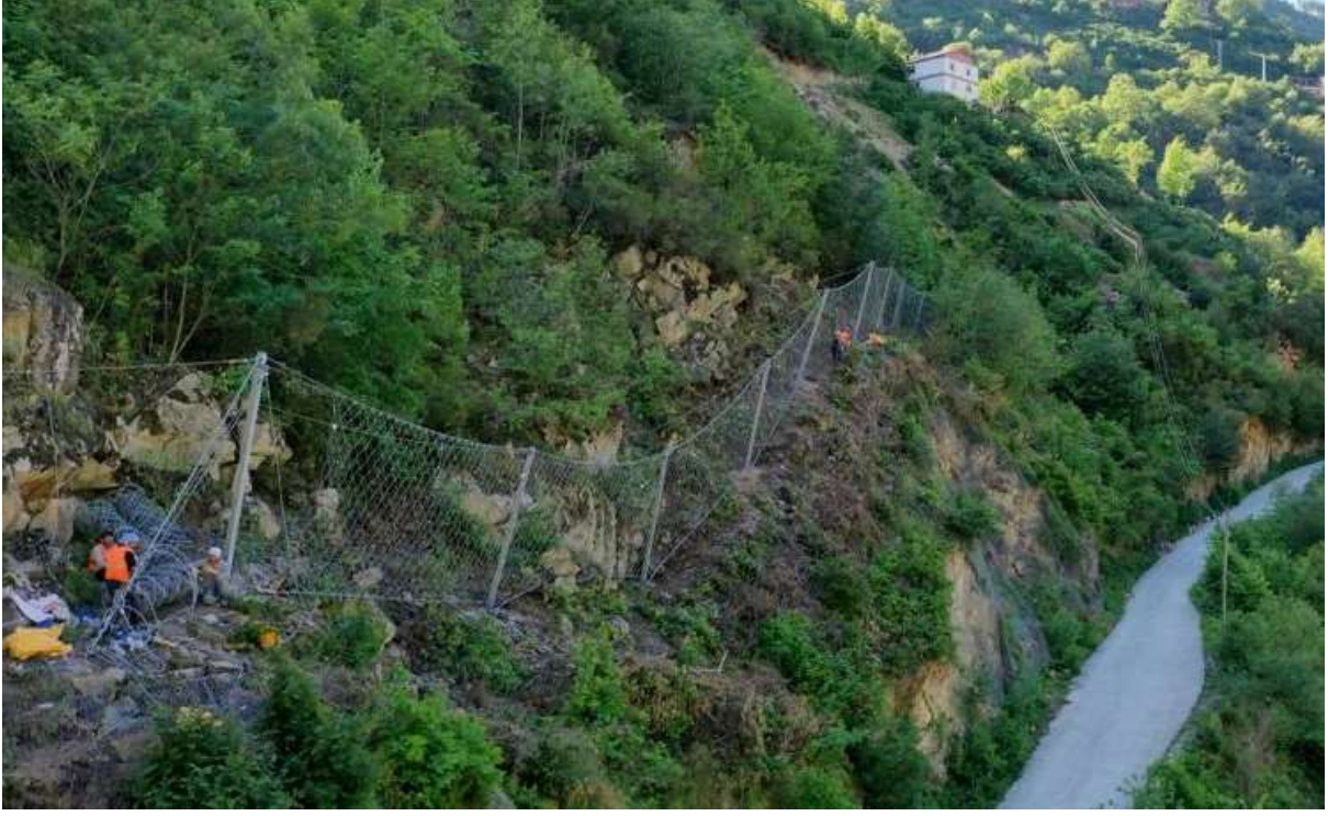
Kürtün Üçtaş Köyü Üçtaş İlköğretim Okulu Heyelan Alanı Çelik Bariyer Uygulaması
