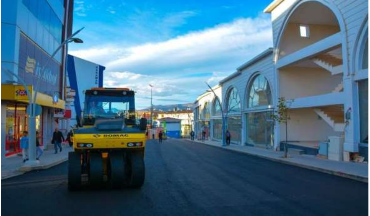
Kelkit Merkez Mahalle İçi Asfalt Yol Yapımı
