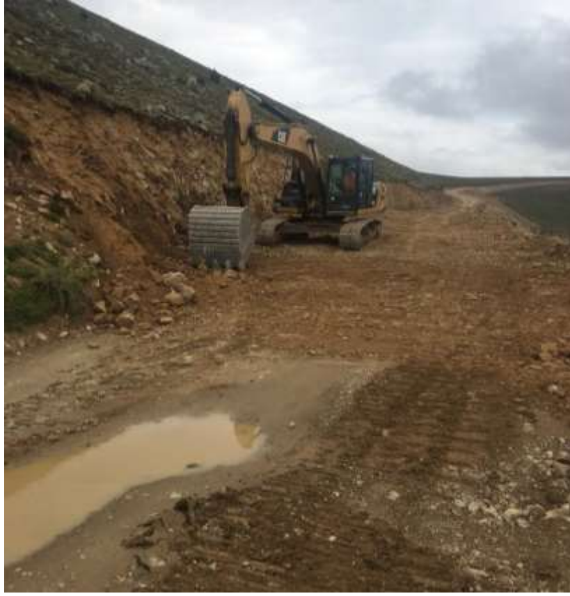
Merkez amlı Ky Kolu Mah.Yolu Onarım alıřması
