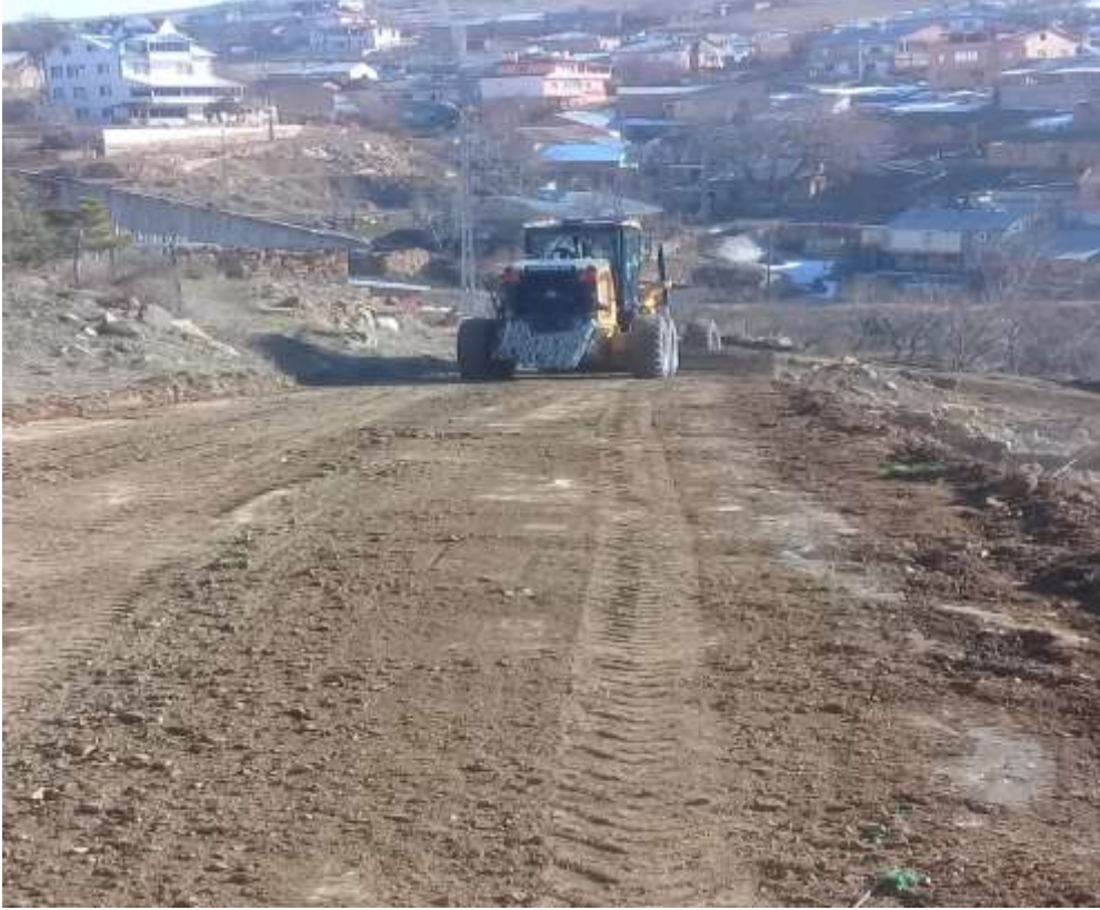
Şiran Bolluk Köyü Bağlantı Yolu Greyderle Reglaj Çalışması
