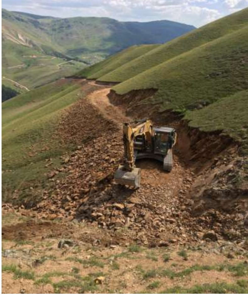
Kürtün Söğüteli Köyü Yayla Yolu Yapım İşi
