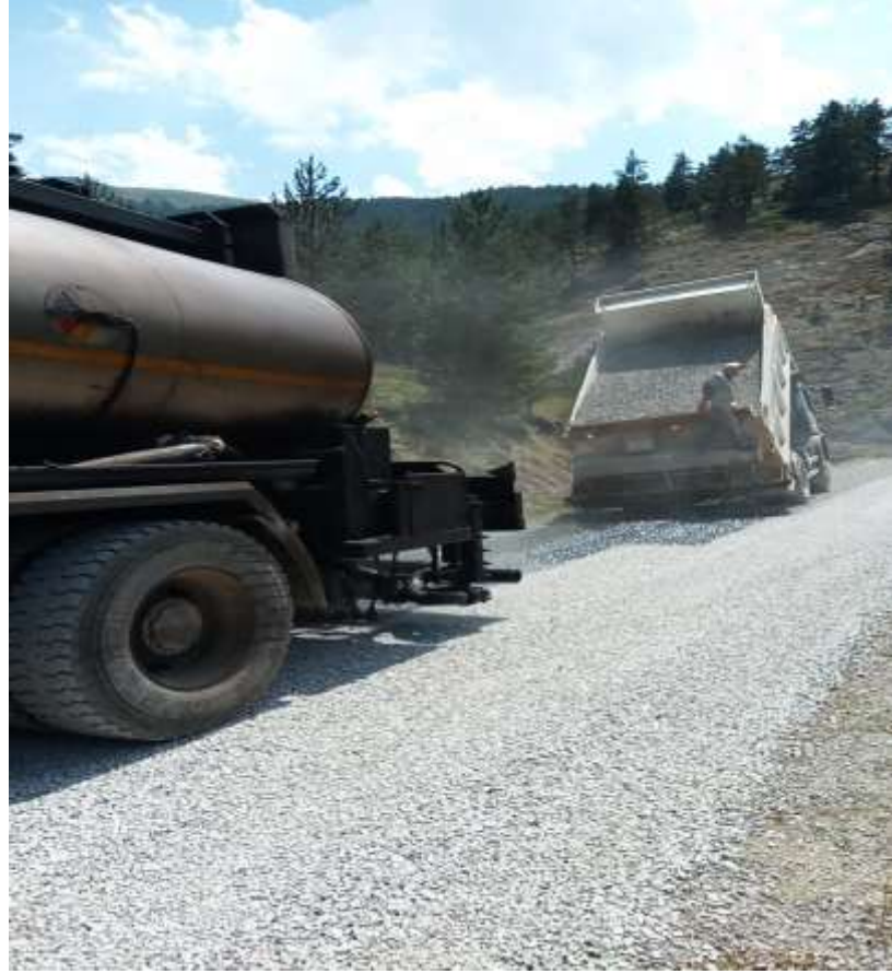
Merkez Yukarı Alıçlı Köyü Asfalt Çalışması
