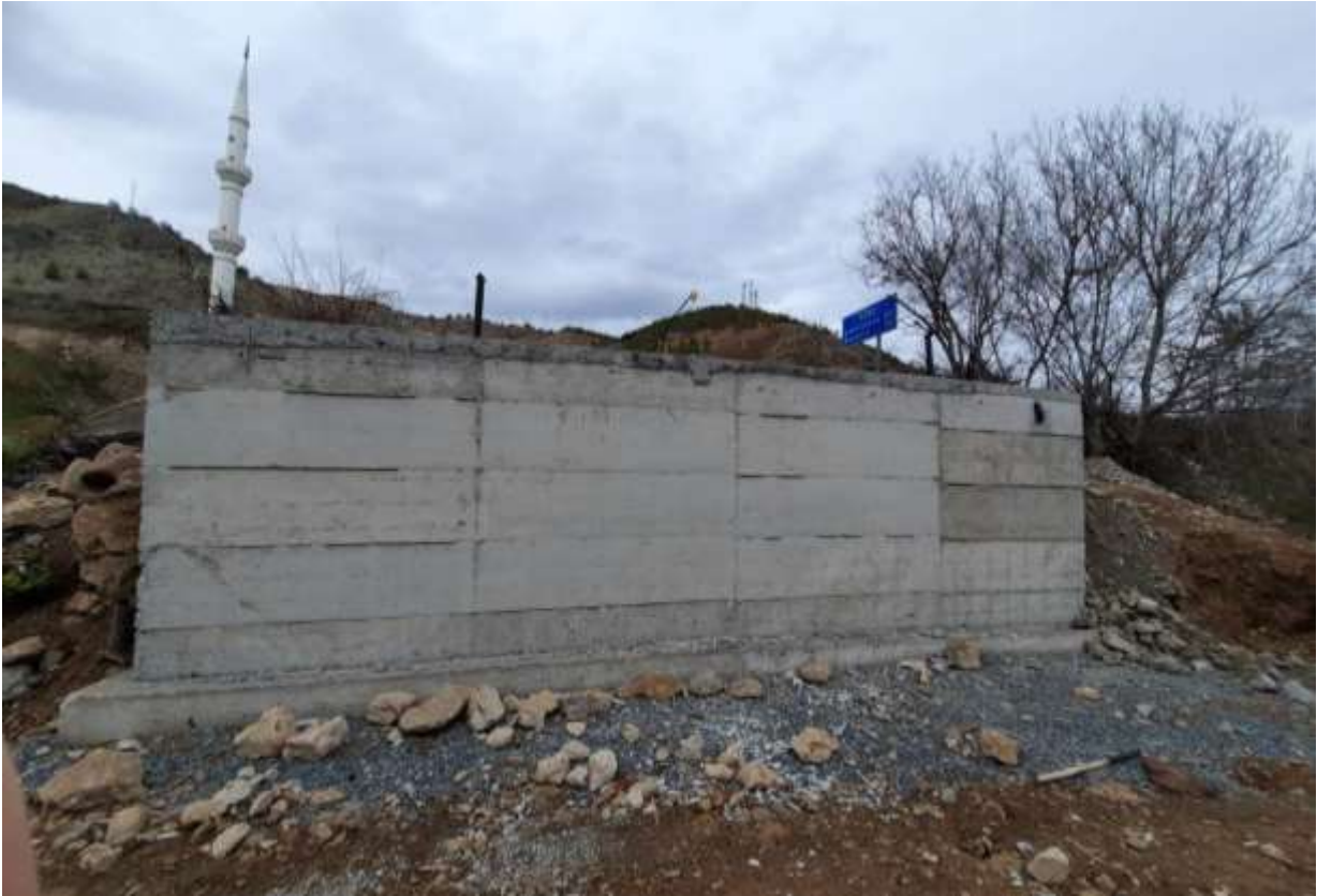
Merkez Kırıklı Köyü 250 Kişilik Foseptik ve Beton Yol Yapım İşi Çalışmaları
