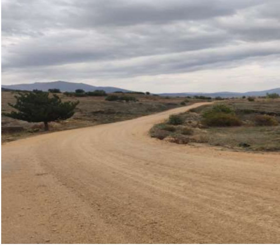
Şiran Çağıl Köyü Stabilize Çalışması
