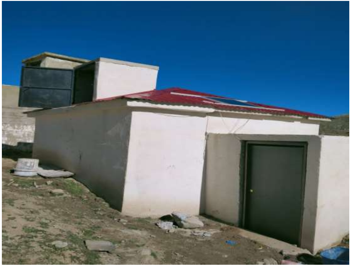
Köydes İçmesuyu Çalışmaları
