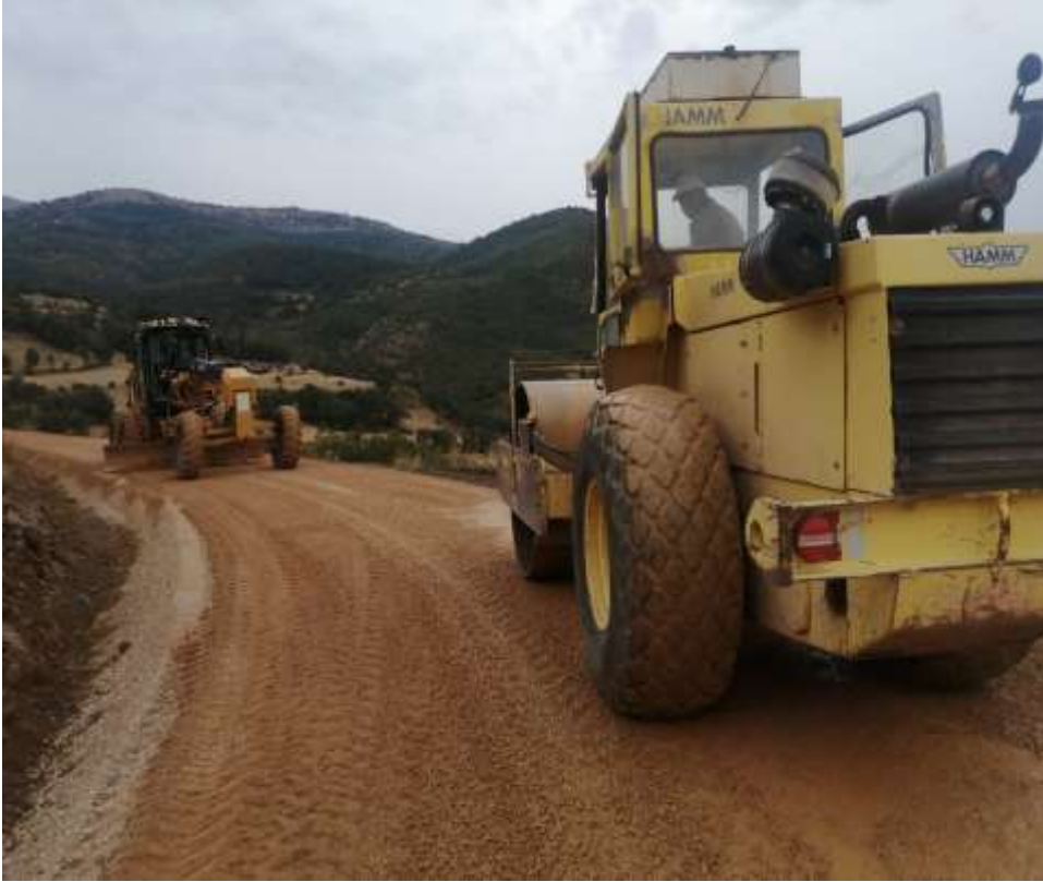
Şiran Başköy Çamlıca Mah. Yolu Asfalt Temel Yapımı
