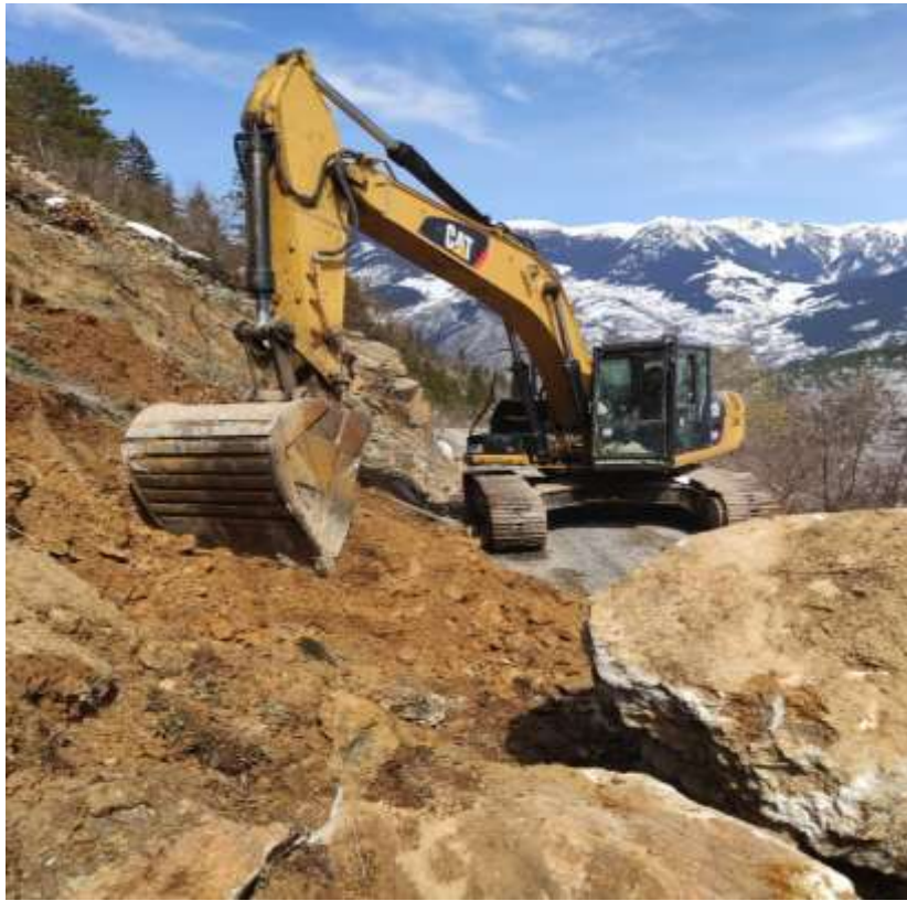
Merkez Yukarı Yuvalı Ky Grup Yolu Onarım alıřması
