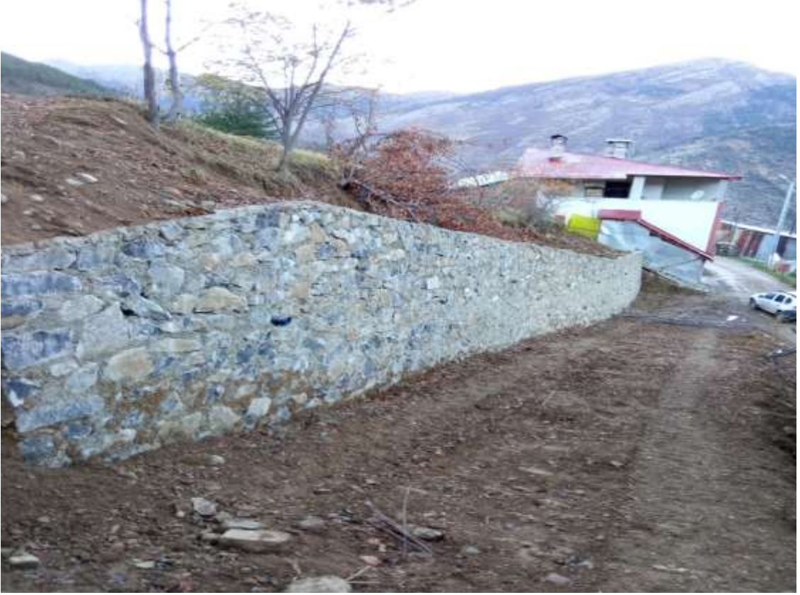
Kürtün Konacık Köyü Taş Duvar Yapım İşi
