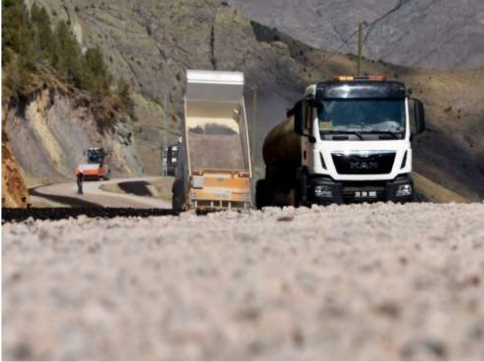
Merkez Sarginkaya Asfalt Çalışması
