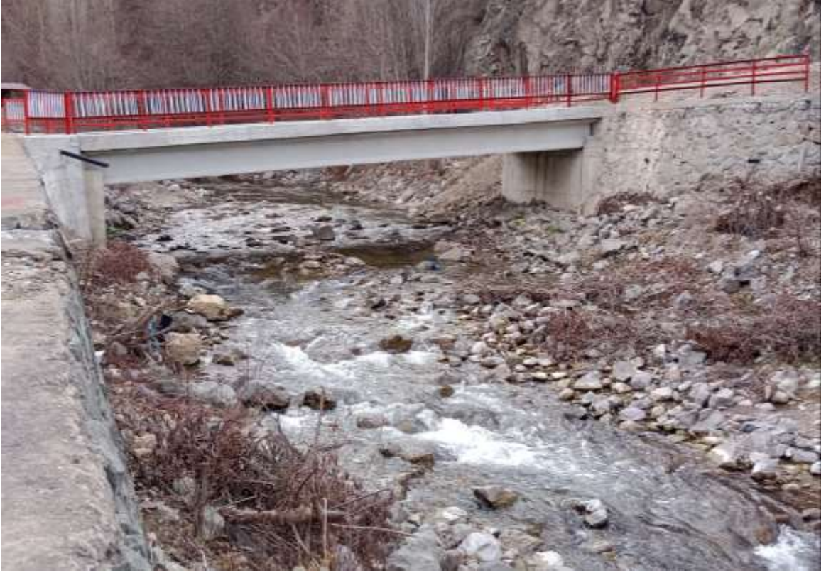
Merkez Dibekli Köyü Köprü Çalışması
