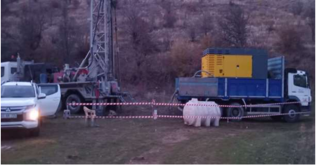
Merkez Olukdere Köyü Sondaj Çalışması
