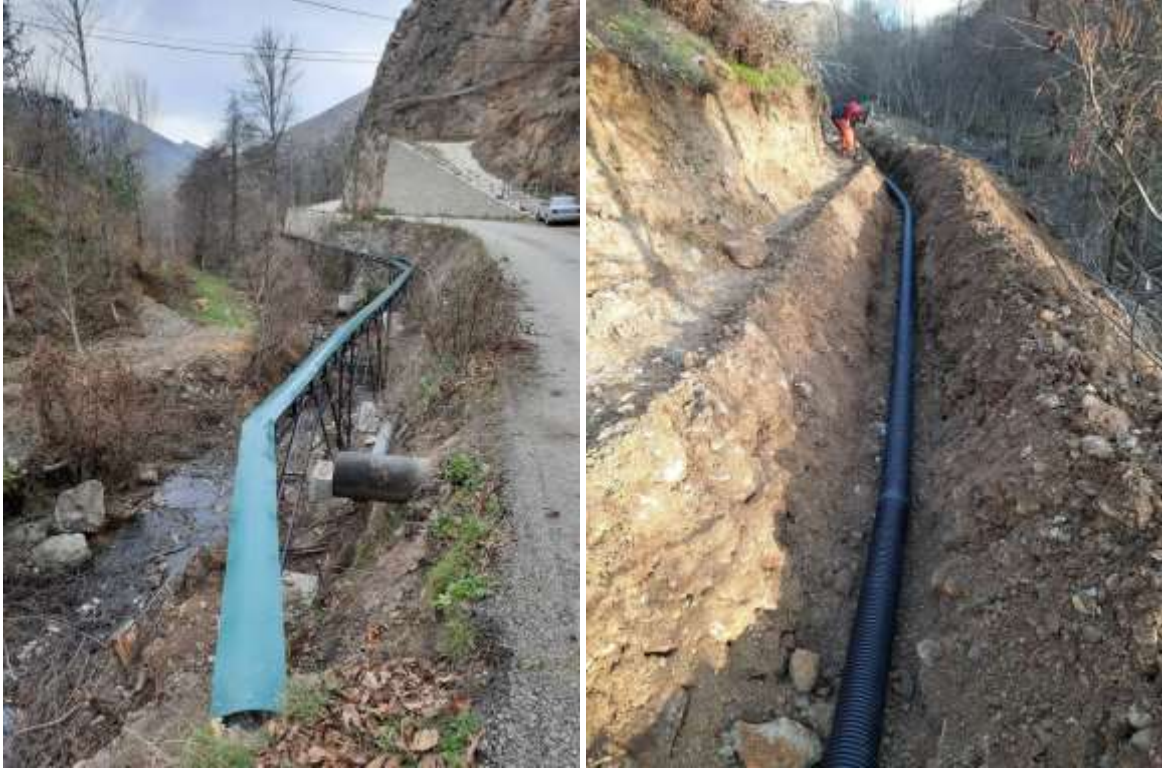
Merkez Yeşilyurt Köyü Kanalizasyon Hattı Yapım İşi Dere Geçişi Platformu
