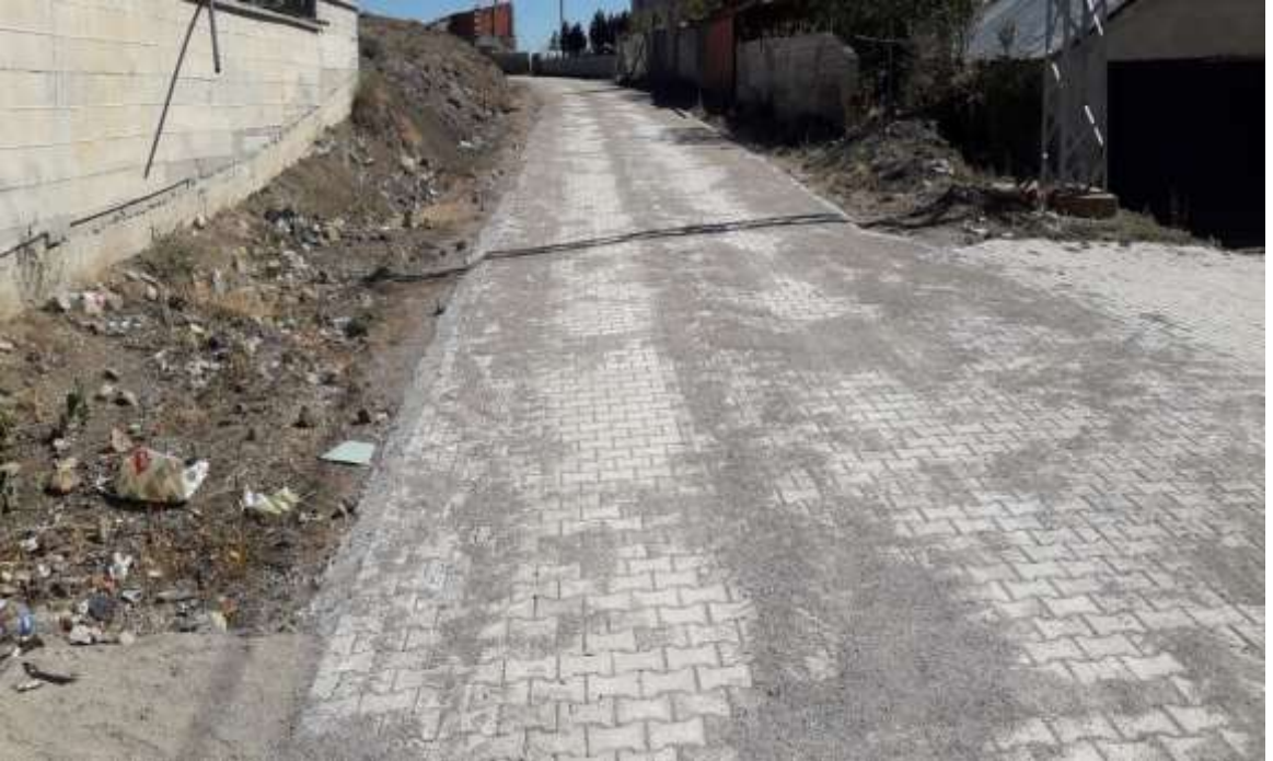
Şiran Boğazyayla Köyü Parke Yapım İşİ
