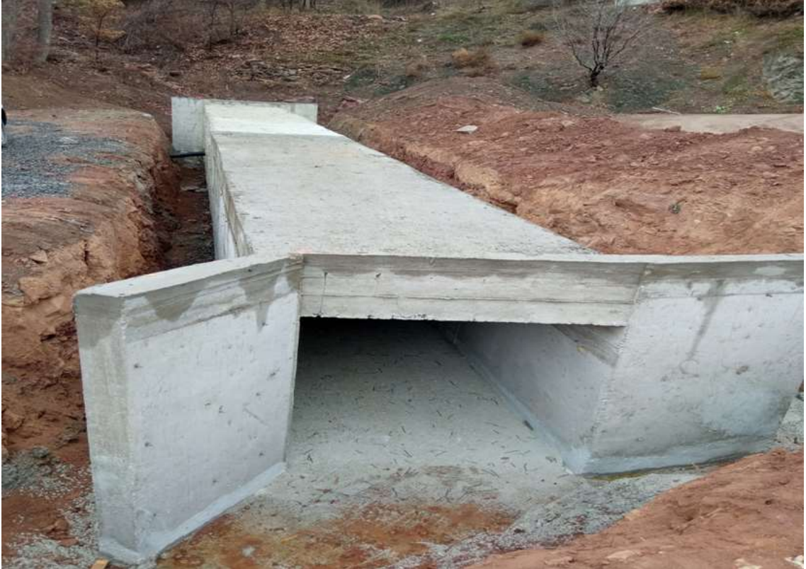
Merkez Çayırardı Köyü Menfez Yapım İşi
