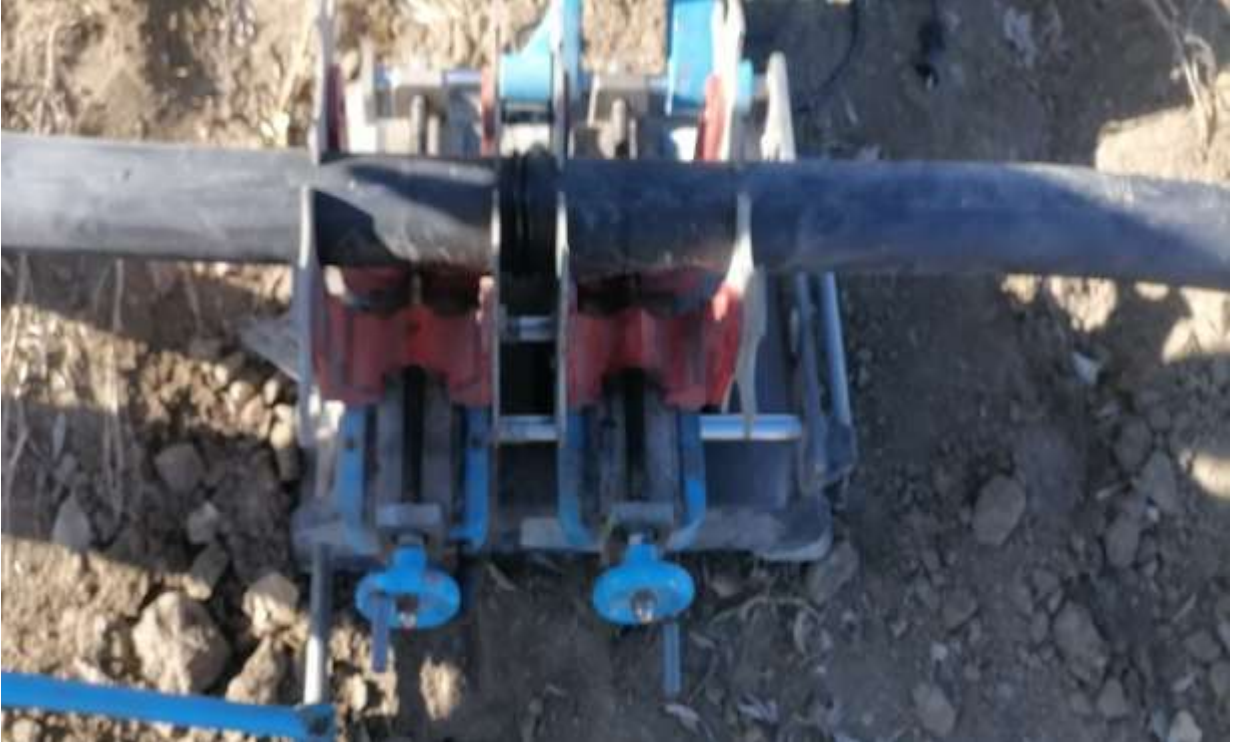
Şiran Çakırkaya Köyü İçmesuyu İsale Hattı Alın Kaynağı Yapım Çalışması
