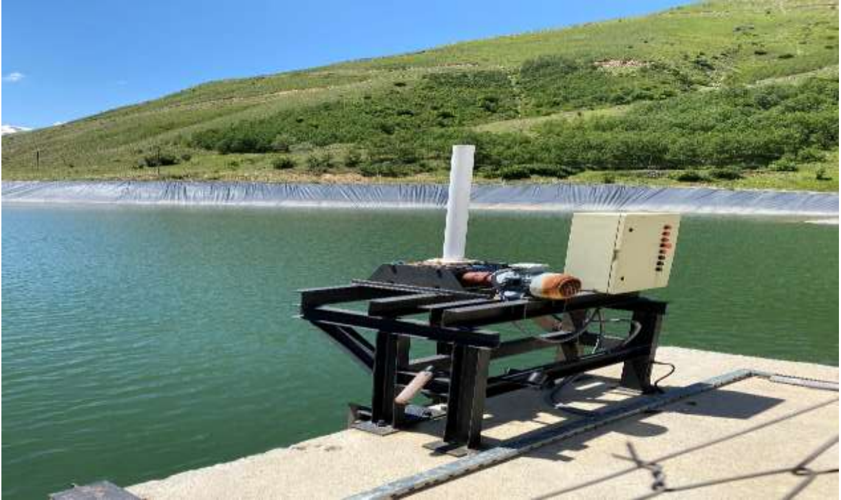
Torul-Güzeloluk Köyü-Hidroelektrik Santrali
