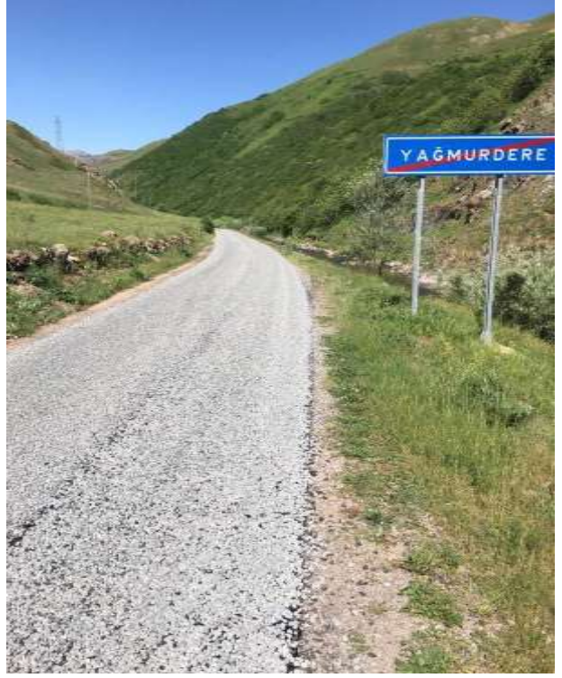
Merkez Yağmurdere Çatak Grup Yolu Asfalt Çalışması
