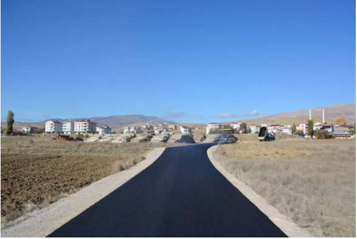
Kelkit Kılıççı Köyü Grup Yolu BSK Asfalt Çalışması
