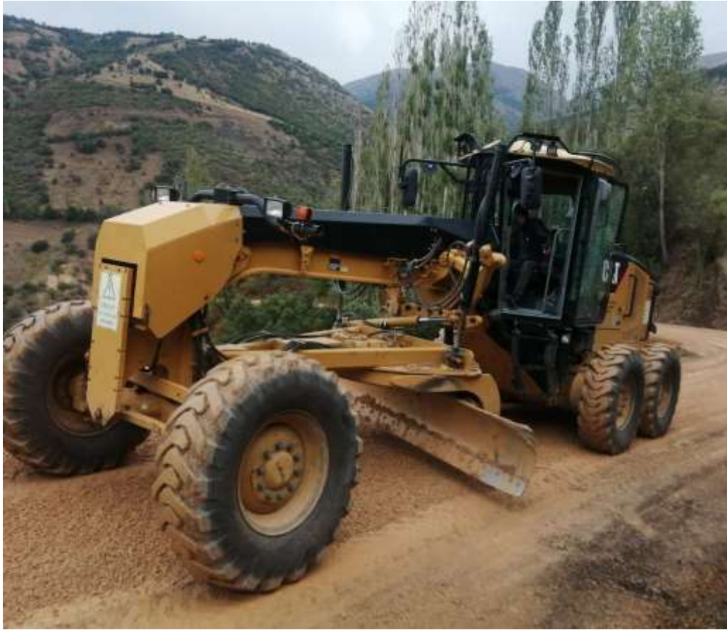
Şiran Pelitli Köyü Stabilize Çalışması
