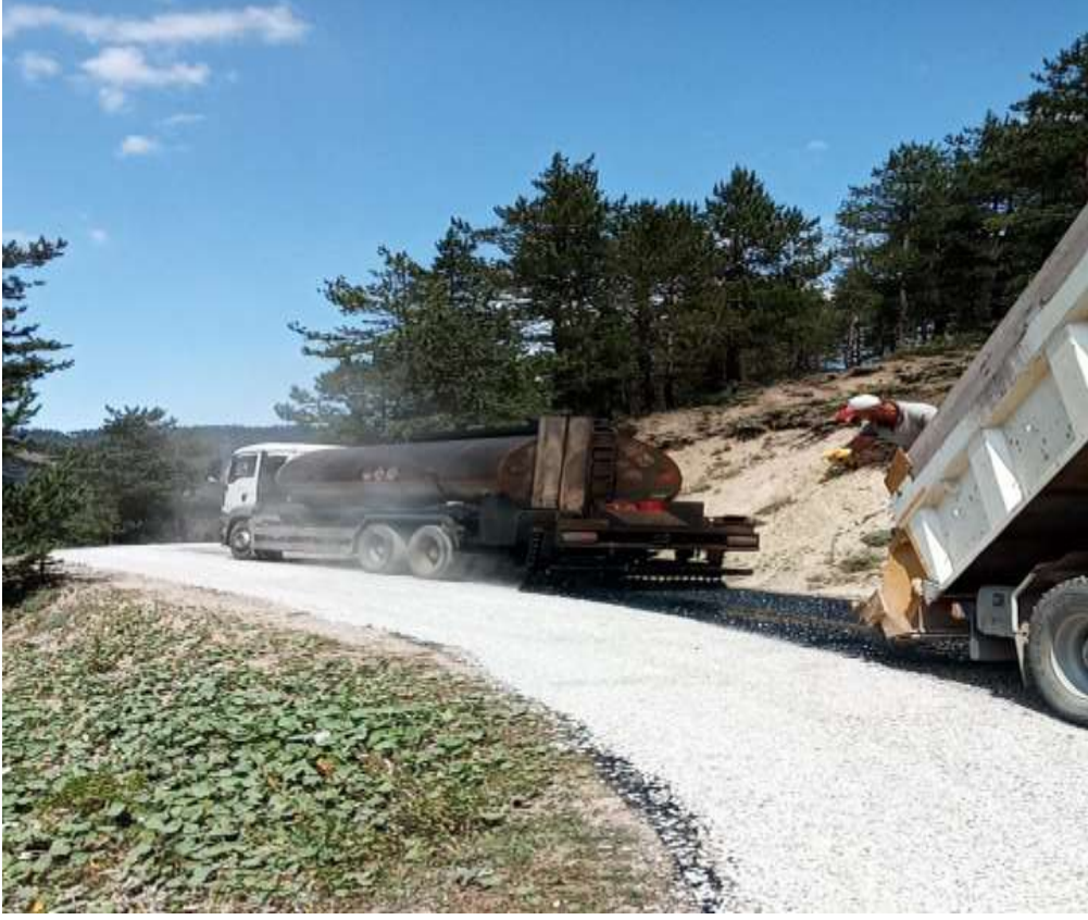
Torul Demirkapı Köyü Asfalt Çalışması
