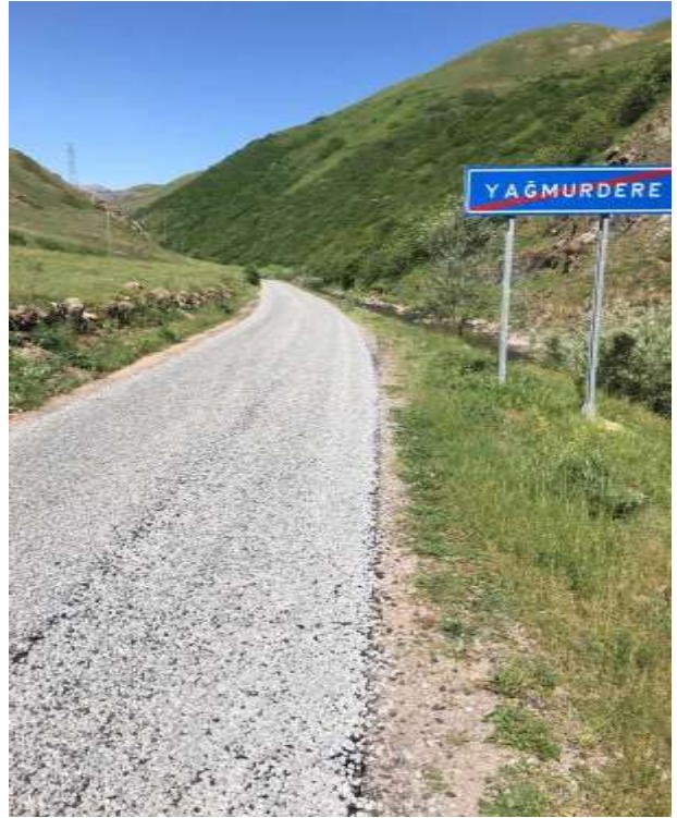
Merkez Yuvalı Köy Yolu Asfalt Çalışması
