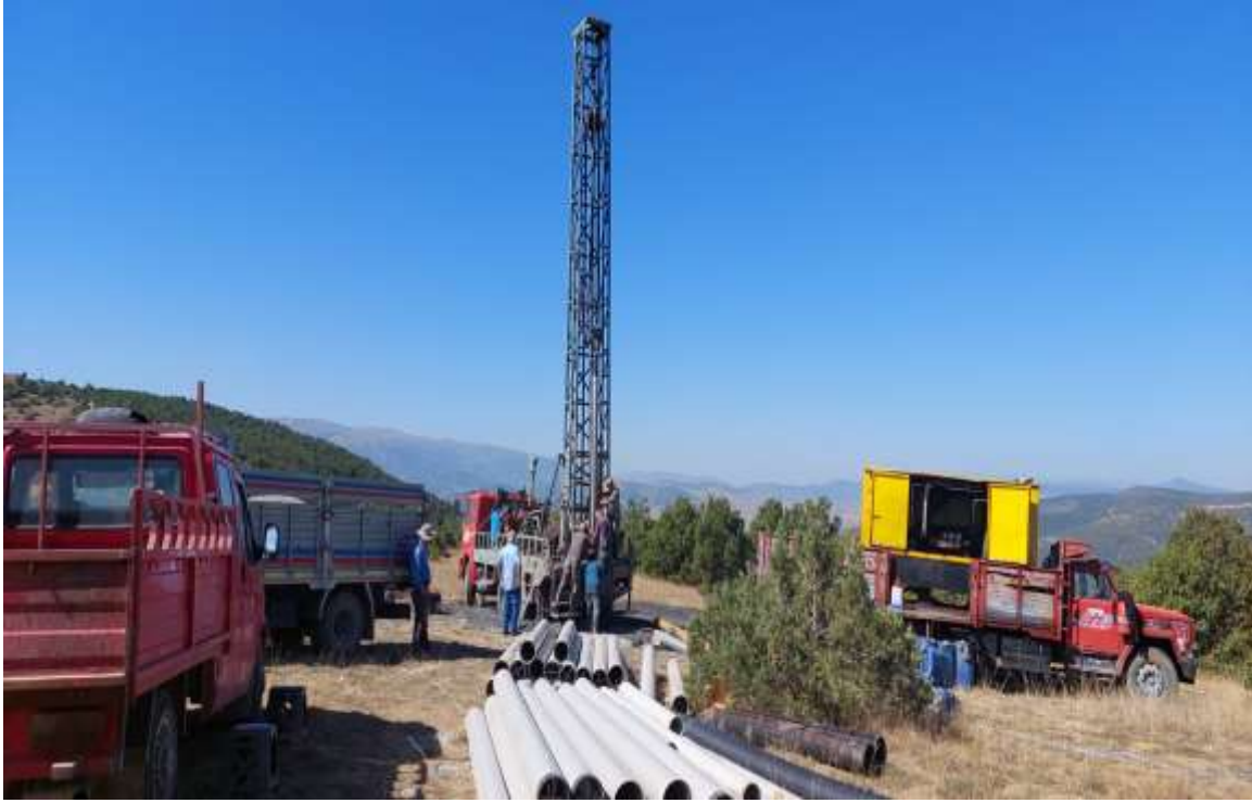
Ardıçlı Köyü İçme Suyu Sondaj Yapım İşi
