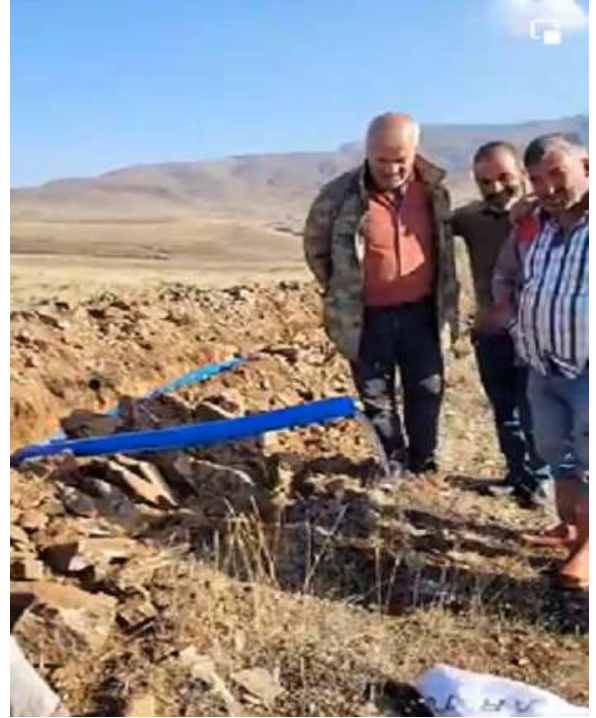
Kelkit Çamur Köyü İçme Suyu İnşaatı
