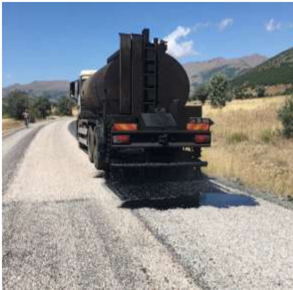
Şiran Sellidere Susuz Grup Yolu Asfalt Çalışması
