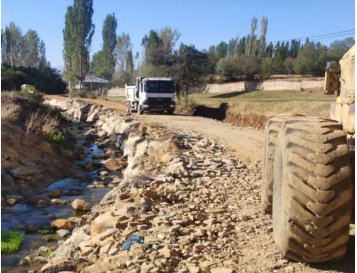
Köse Örenşar Arazi Yolu Malzemeli Bakım Çalışması
