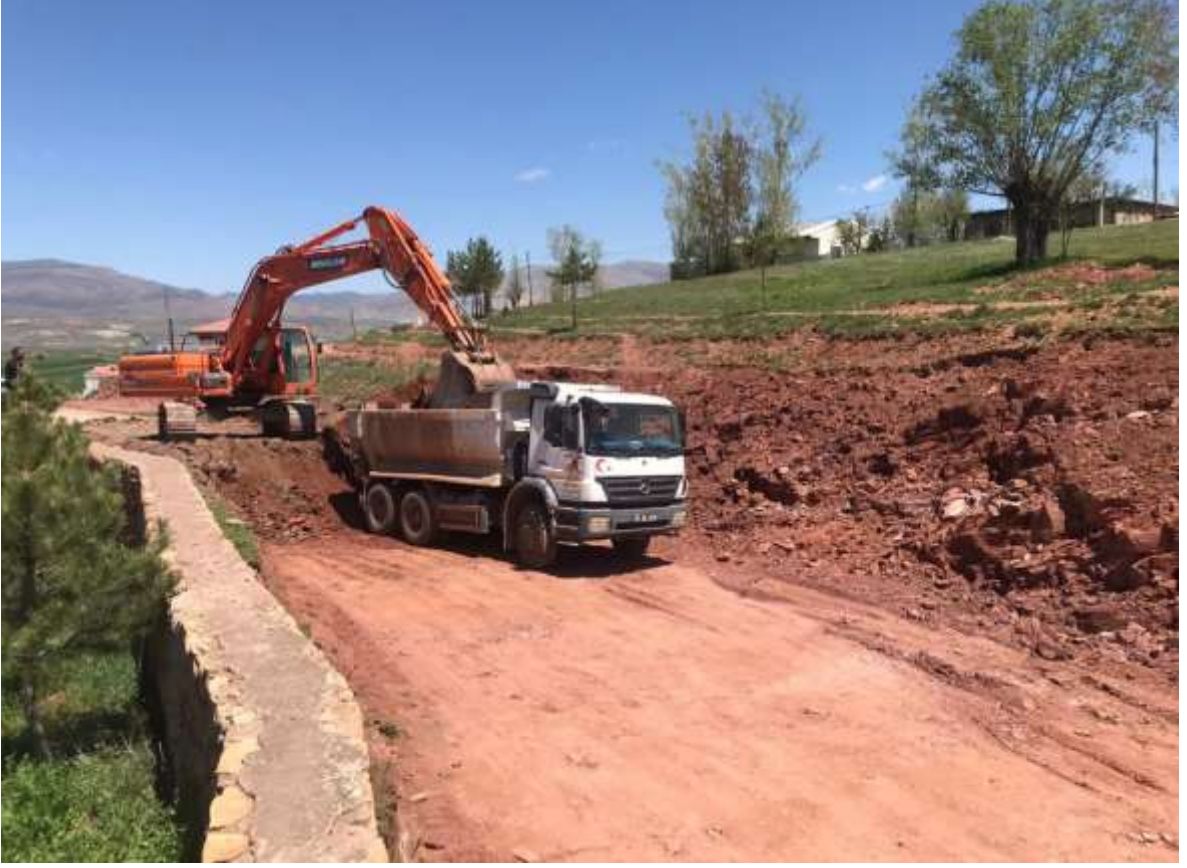
Kelkit Kınalıtaş Mahalle Yolu Onarım Çalışması
