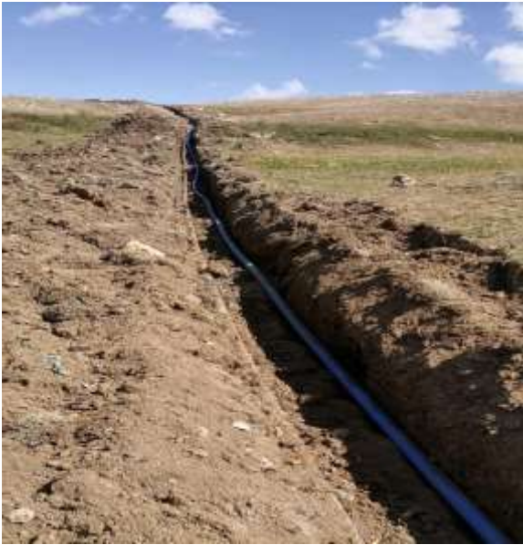
Kelkit Gürleyik Köyü İçme Suyu Yapım İşi
