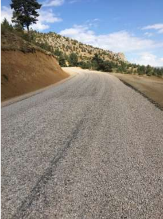
Merkez Gümüşkaya Köy Yolu Asfalt Çalışması
