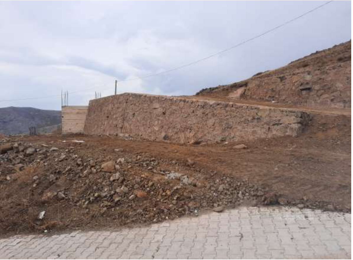
Duymadık Köyü Köy Konağı Taş Duvar ve Parke Yapım Çalışmaları
