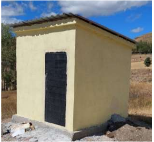
Köse Altıntaş Köyü İçme Suyu Terfi Hattı Yapım İşi
