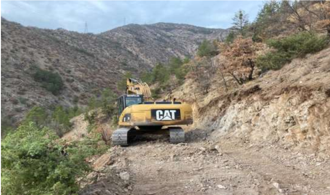
Torul Harmancık Köyü Yayla Yolu Yapımı
