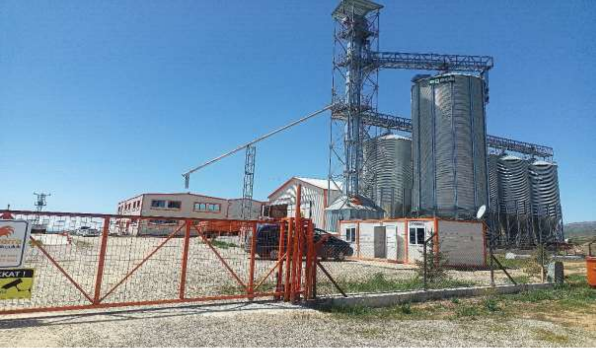
Köse- Öreñsar Köyü- Yumurta Üretim Tesisi ve Tavuk Çiftliđi
