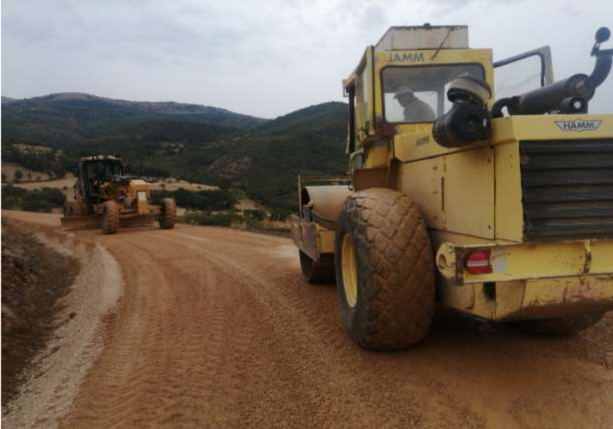
Şiran Yukarı Kulaca Köy Yolu Asfalt Temel Yapımı
