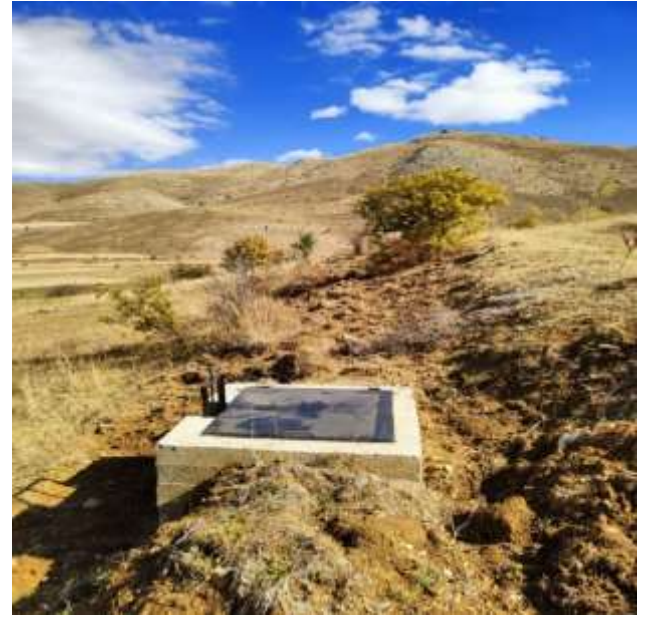
Kelkit Deliler Sulama Tesisi
