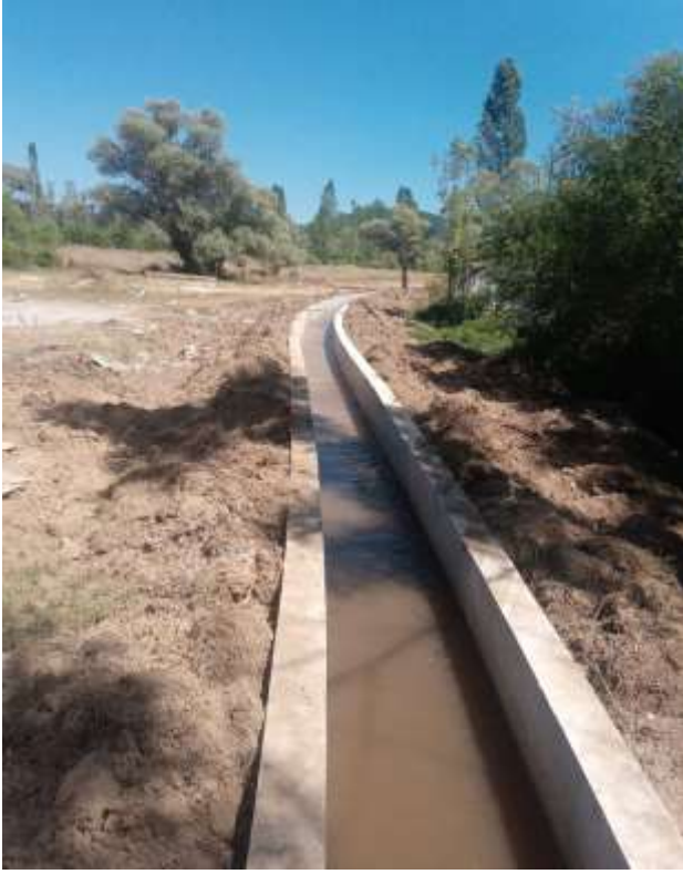
Şiran Sarıca Sulama Tesisi
