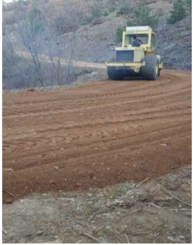
Şiran Söğütalan Mahalle Yolu Stabilize Çalışması
