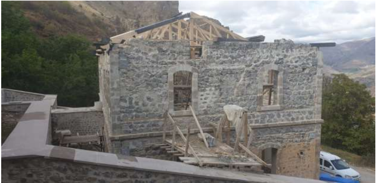
Süleymaniye Mahallesi Sarı Mektep (Rum Okulu) Restorasyon Uygulama İŖi ÇalıŖmaları
