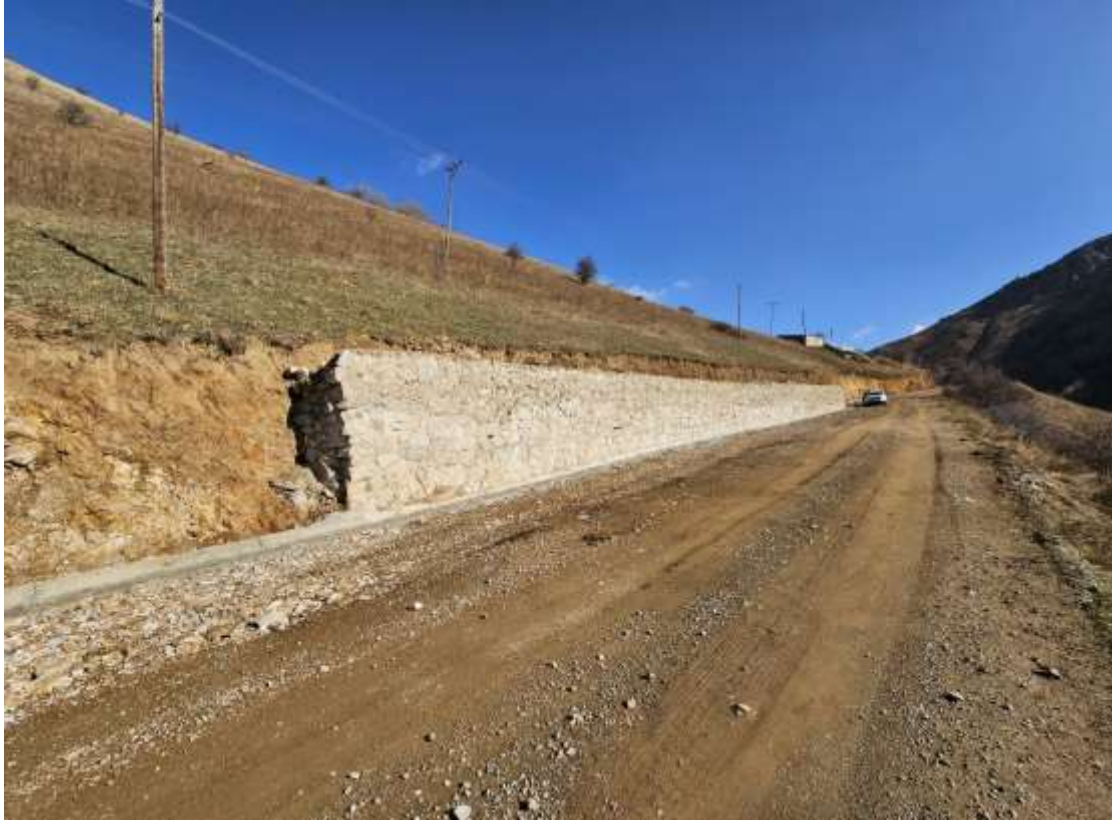
Kürtün Tilkecek Taş Duvar Yapım İşi
