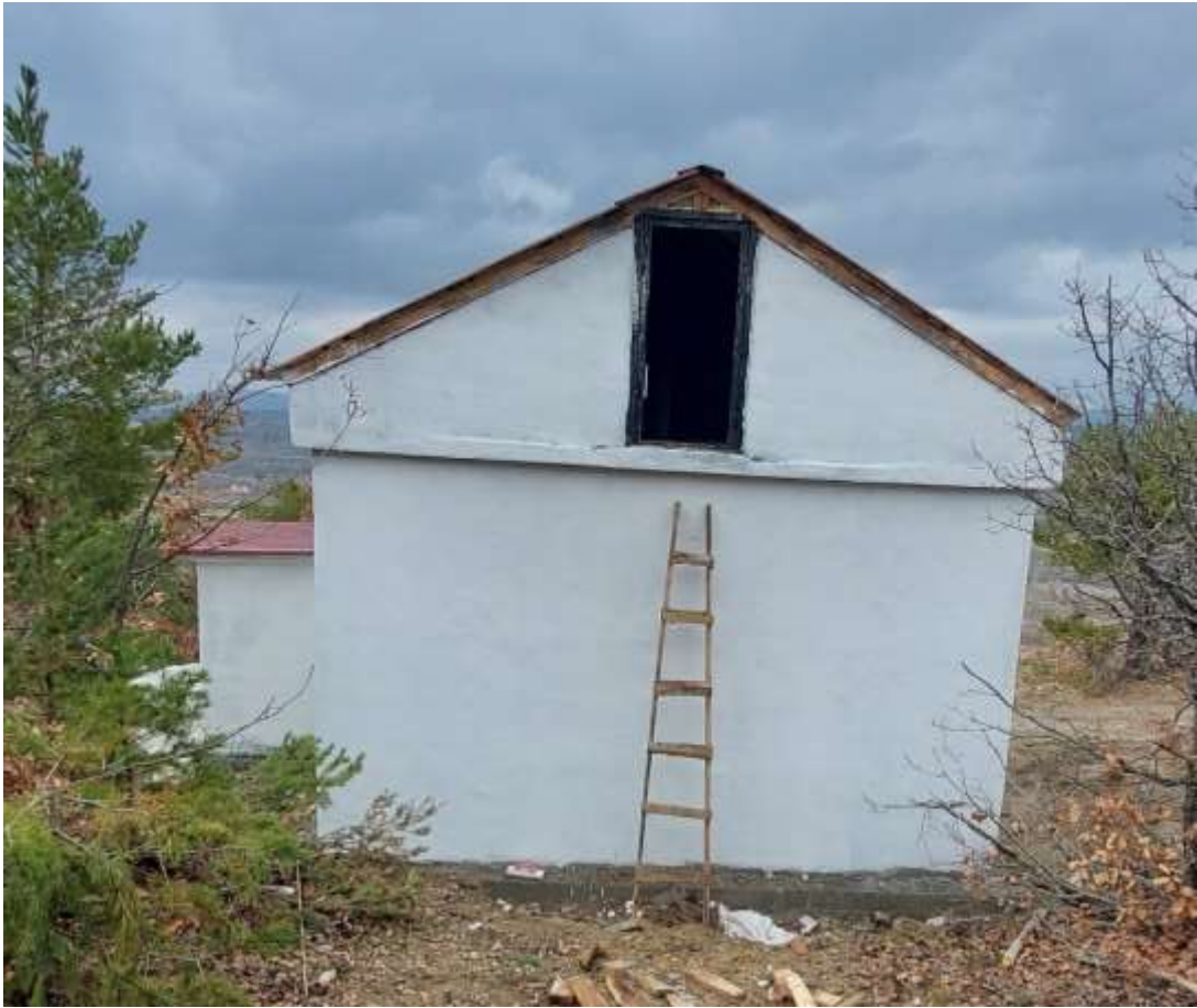
Şiran Alacahan Köyü 50 Ton Depo ve Şebeke Bağlantıları Yapım İşi
