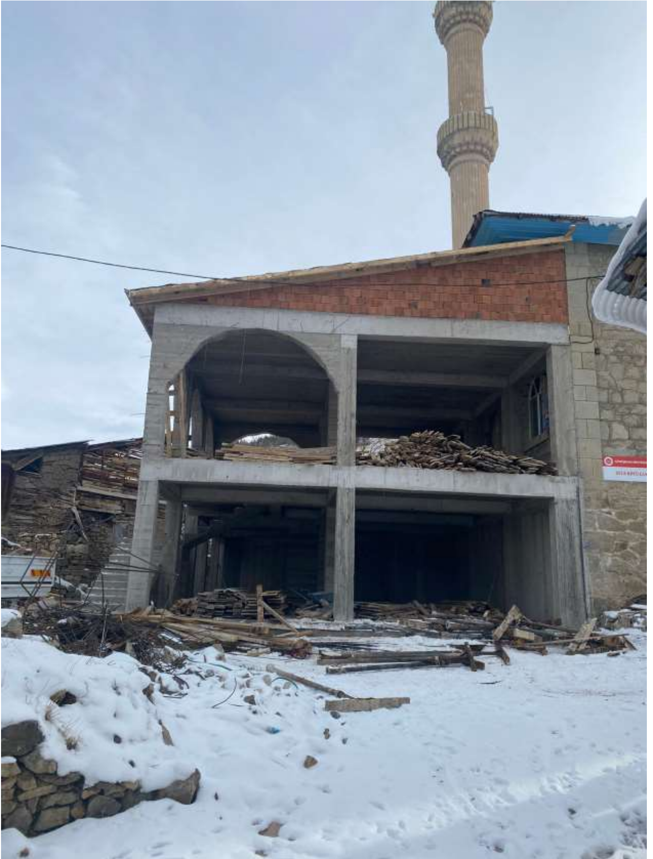
Süle Köyü Camii Ek Bina İnşaatı Yapım İşi Çalışmaları
