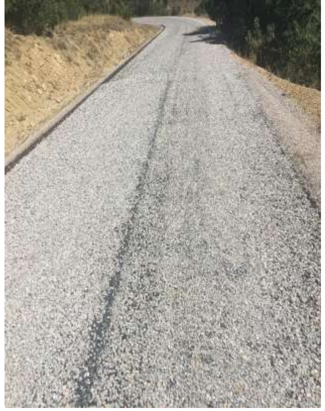
Şiran Cavlan Köy Yolu Asfalt Çalışması
