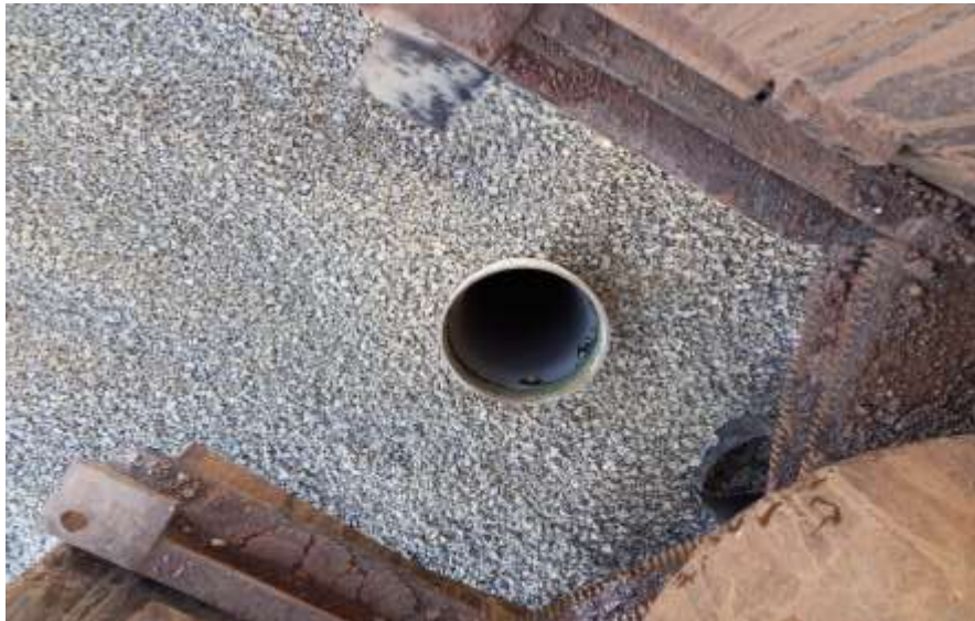
Şiran Söğütalan Köyü İçme ve Kullanma Suyu Sondaj Yapım İşi
