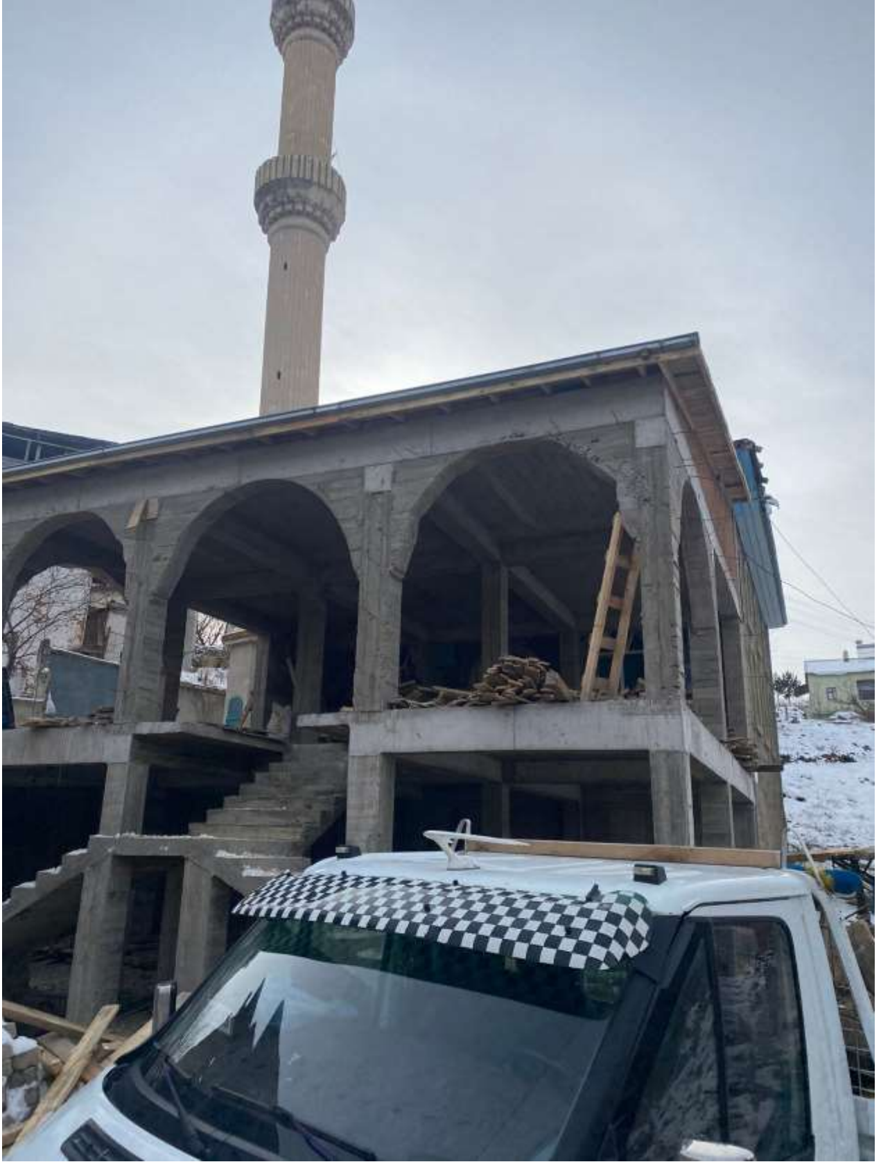
Süle Köyü Camii Ek Bina İnşaatı Yapım İşi Çalışmaları
