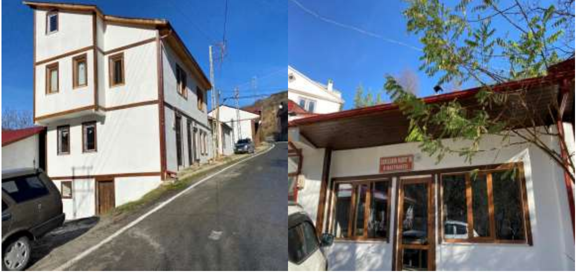
Torul İlçesi Zigana Köyü Sokak Sağıklaştırması Yapım İşı
