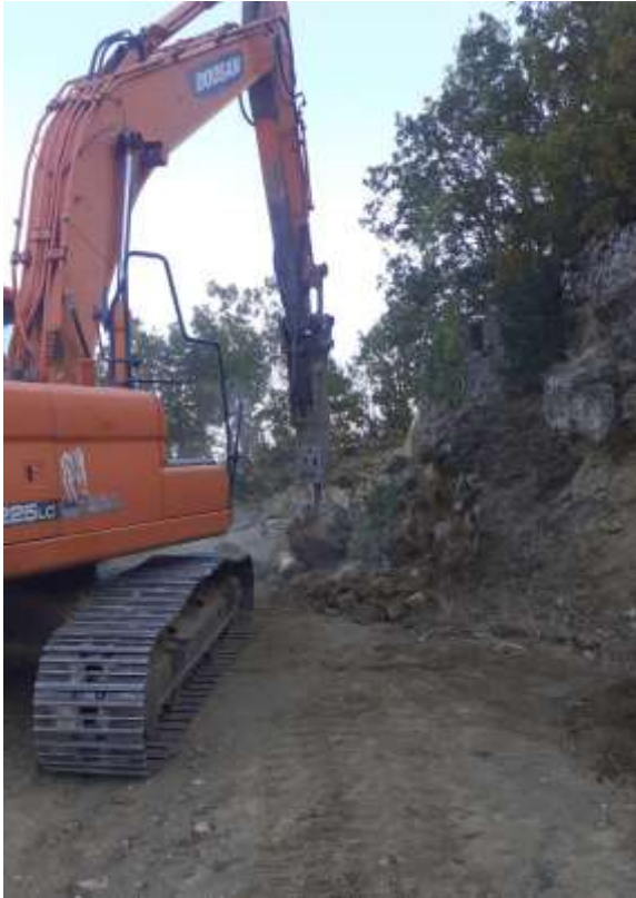
Şiran Başköy Köy Yolu Onarım Çalışması
