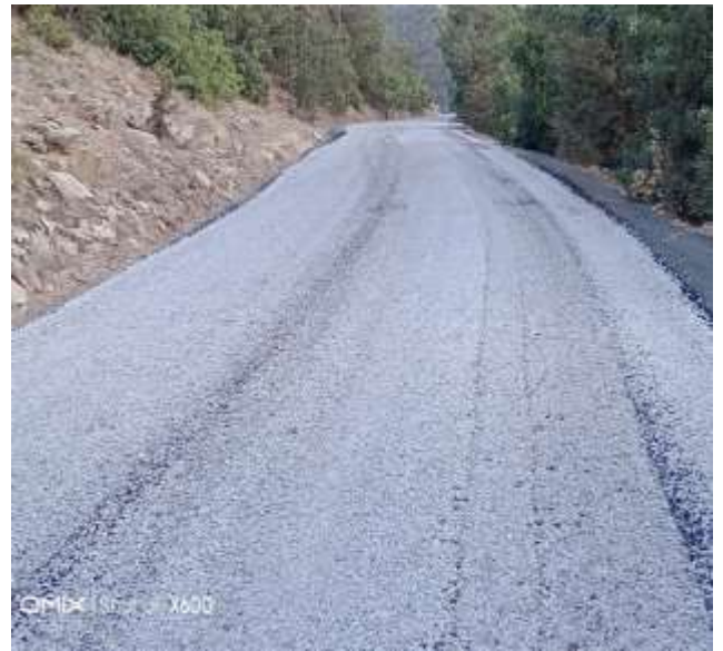
Şiran Araköy – Yolbilen Grup Yolu Asfalt Çalışması
