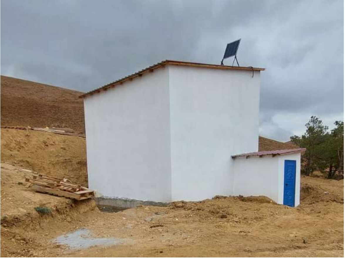
Gümüşhane Köse Salyazı Köyü 50 Ton Depo ve Şebeke Bağlantıları Yapım İşi
