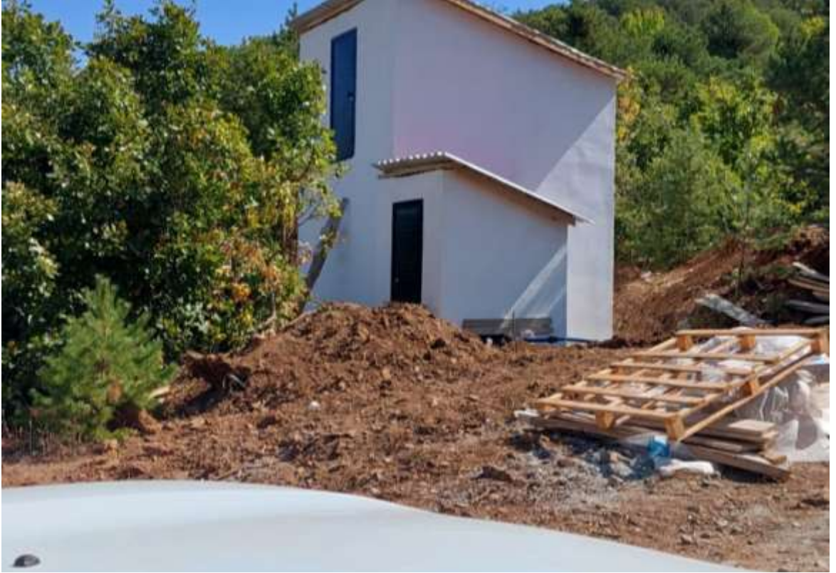
Kelkit Sadak Köyü İçme Suyu Depo Yapım İşi
