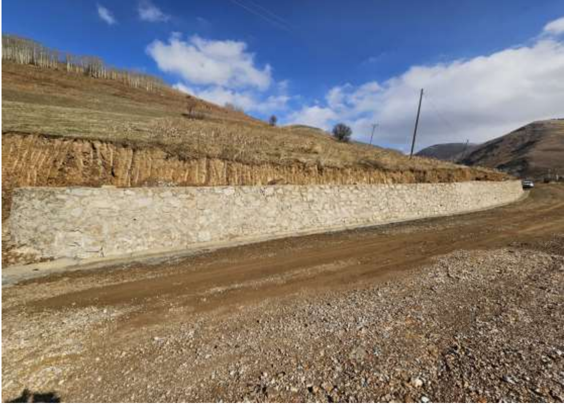
Kürtün Beytarla Taş Duvar Yapım İşi
