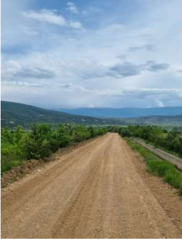
Kelkit Bezendi Mahalle Yolu Stabilize Çalışması
