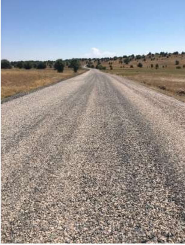
Şiran Yukarı Kulaca Köy Yolu Asfalt Çalışması
