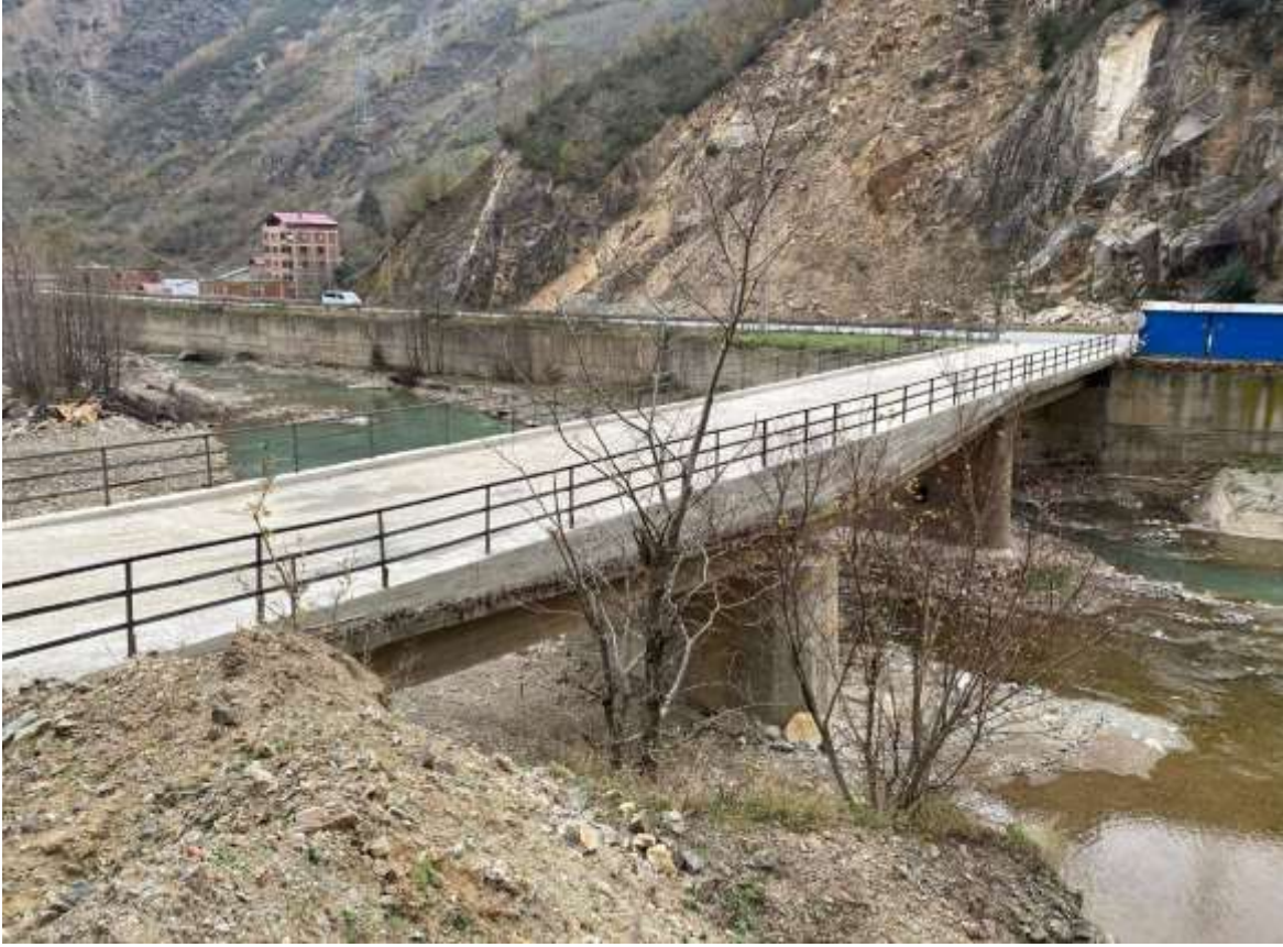
Kürtün Üçtaş Köyü Köprü Çalışması
