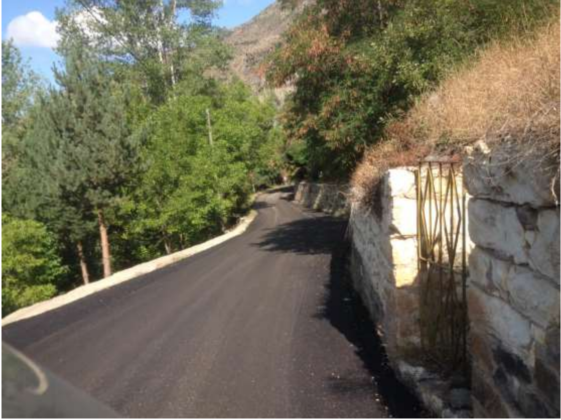
Merkez Yeşildere Mahalle Yolu BSK Asfalt Çalışması
