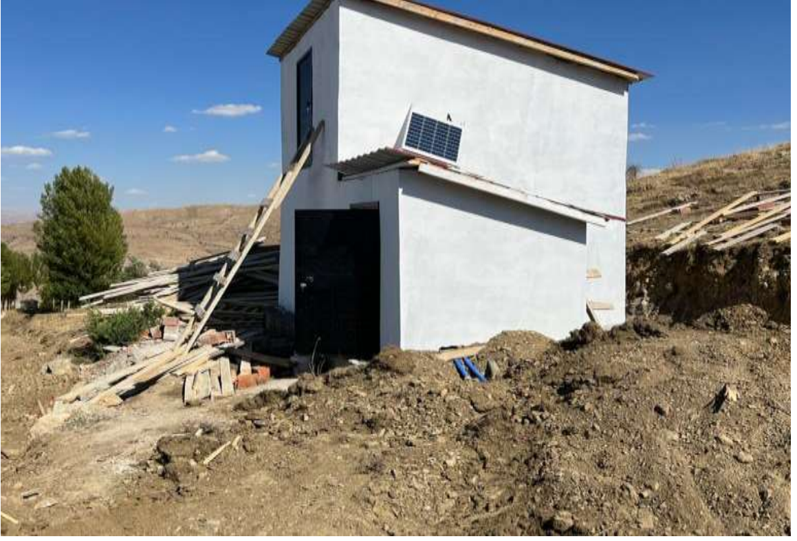
Kelkit Dölek Köyü İçme Suyu Yapım İşi
